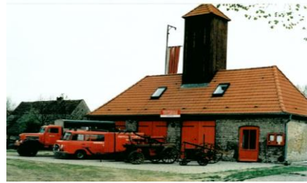
Abbildung 3 - Die Alttechnik vor dem alten Gerätehaus
